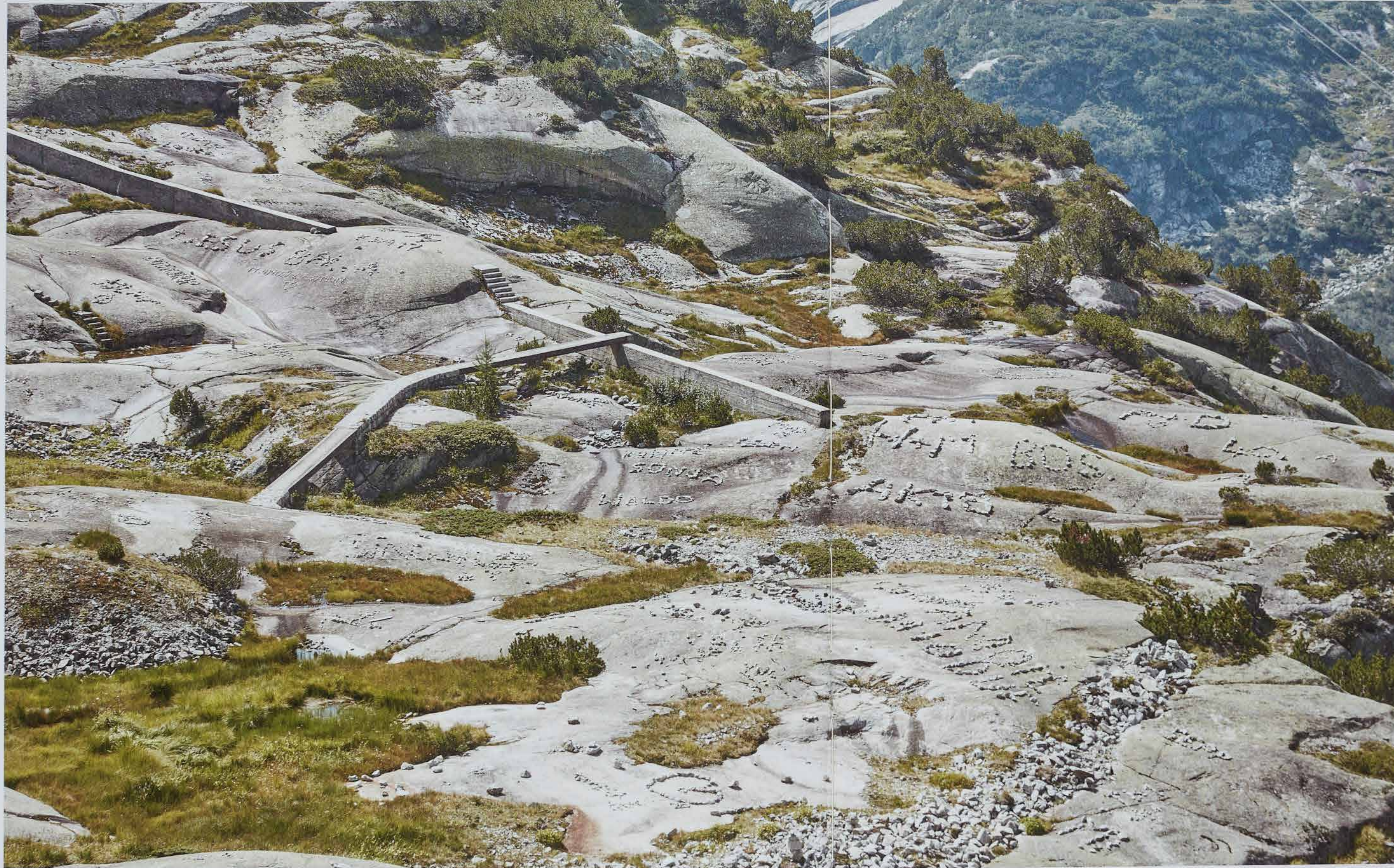
Vorfeld der Gelmer Staumauer
