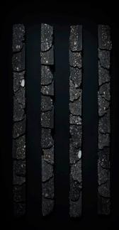
Vier längliche Wandpaneele aus Asphaltscheiben, ebenfalls mit Loch versehen und auf eine Unterkonstruktion aus Holzlatten aufgeschraubt.
