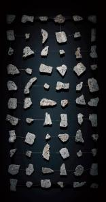
Ein halbrundes Element aus schmalen Asphaltscheiben, ebenfalls mit Loch versehen und auf eine Unterkonstruktion aus halbrunden Holzlatten aufgeschraubt. Ein Fassadenelement, bestehend aus einem Holzrahmen, Drahtseil und darin, durch ein kleines Loch in der Mitte eingewebten, kleinen Betonscheiben.
