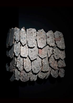
Ein Eck-Element aus Betonscheiben, die mit einem Loch versehen und an eine Unterkonstruktion aus gebogenen Holzlatten geschraubt werden.
